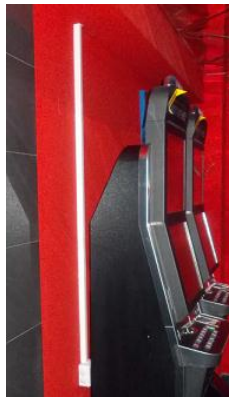
Рисунок 6.2.1 – Монтаж линий связи на стене
